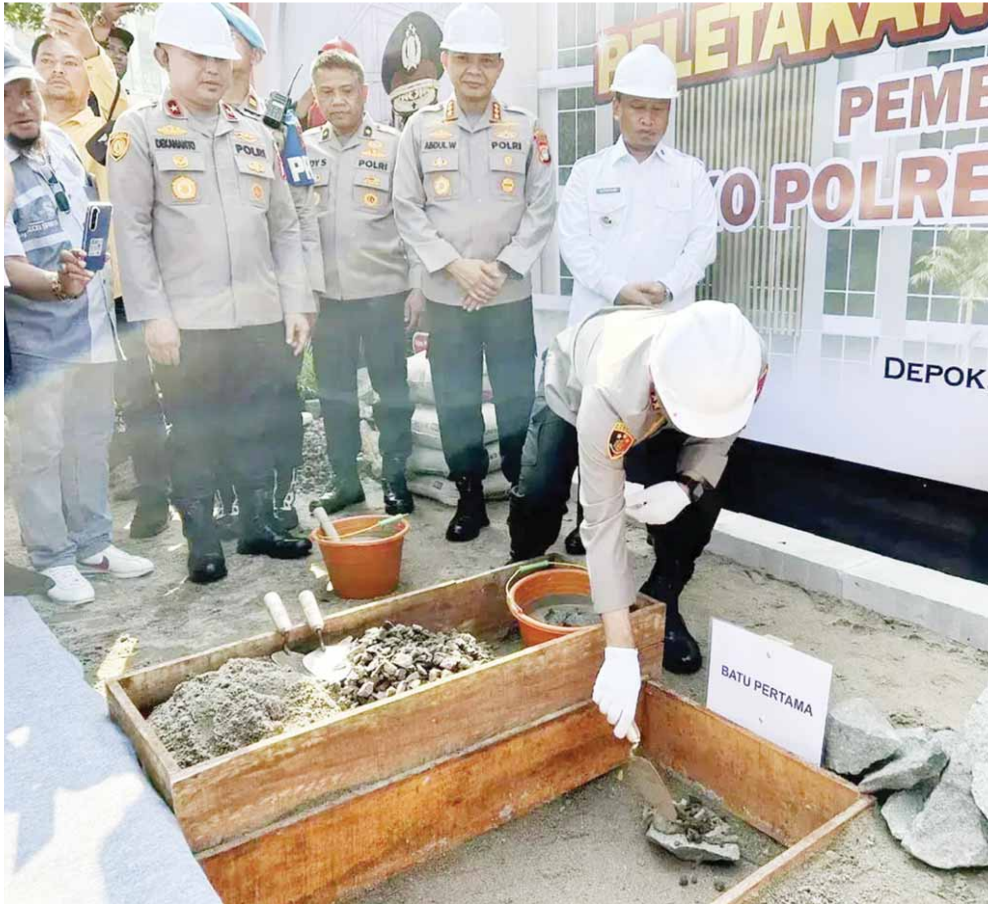
MULAI DIBANGUN: Peletakan batu pertama pembangunan gedung baru Polres Metro Depok dengan anggaran hampir Rp 40 miliar, Rabu (29/4) kemarin.
